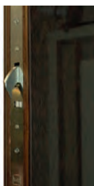
Semi-automatisch haakslot (Winkhaus) Serrure semi-automatique à crochets
