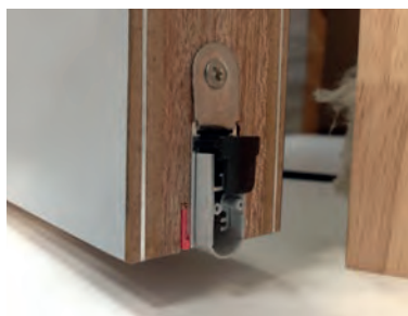
Automatische valdorpel Seuil tombant automatique
