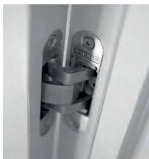
Onzichtbare scharnier Paumelle invisible
